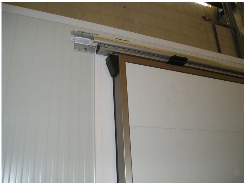
6º Colocación del segundo tramo del carril y comprobación del nivel.
